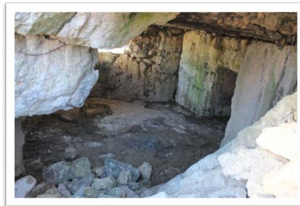
При отходе советских войск ДОТ был взорван. Взрывом практически снесена задняя стенка, разрушен сквозник входа, имеются небольшие трещины в стенах вдоль крыши.
